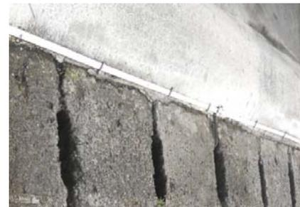
Conducteur en cuivre au-dessus du cheminement des fourreaux pour la protection des câbles
