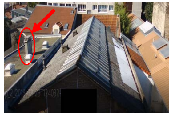
Vue prise du drone avec cheminée sur la toiture
